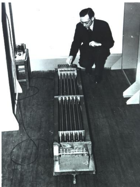
Ultradźwiękowa pamięć rtęciowa źródło: Wikipedia
