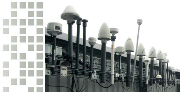
Widok dachu zakładu produkcyjnego zapełnionego antenami GPS
